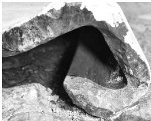
Рис. 5. Замок шпунтовой сваи после ее извлечения
